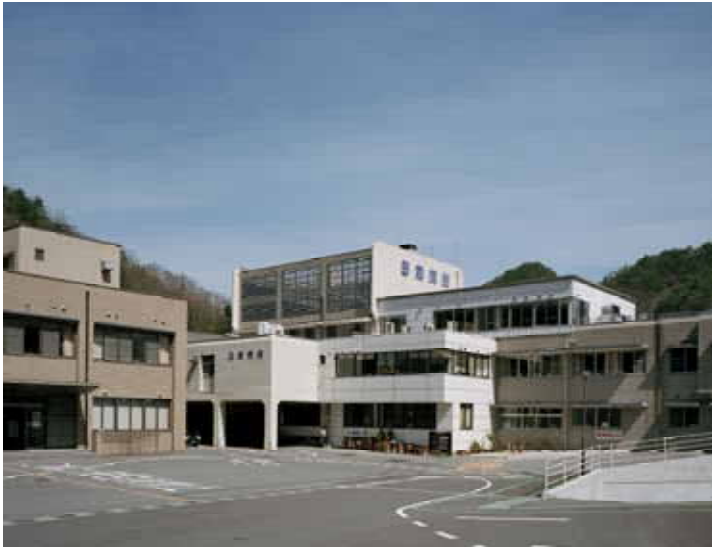
増築後南西側全景
