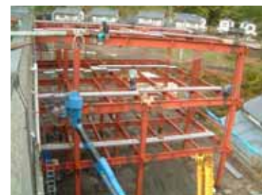
本館増改築工事
