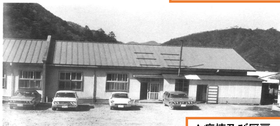
▲病棟及び厨房
